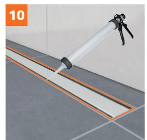
**Gebruik voor het verlijmen van de meegeleverde Kerlox-flens flexibele tegellijm EN 12004:C2E-S1 (in de handel gekend als 'superflexlijm'). Voor de overlappende delen gebruikt u een 2-componentenlijm.**
